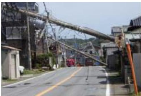
【令和元年9月 台風15号による電柱倒壊状況】
