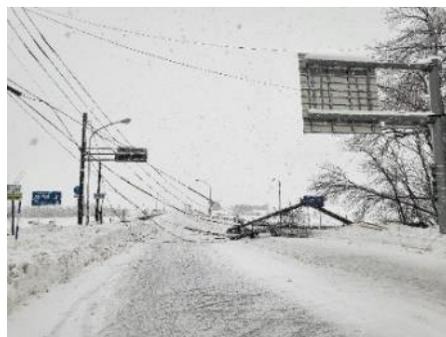
【令和4年12月 暴風雪による電柱倒壊状況】
