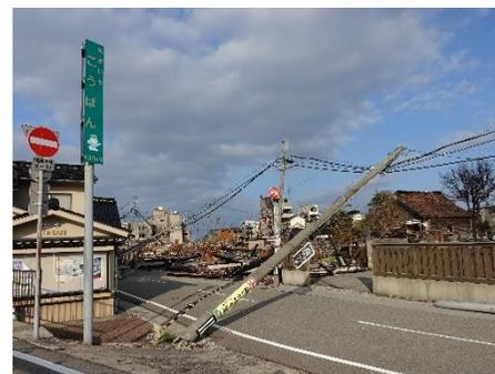
【令和6年1月 能登半島地震による電柱倒壊状況】
