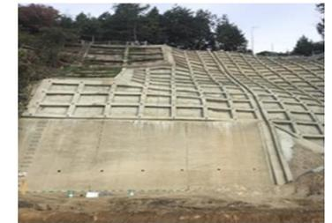
斜面の崩壊防止対策
